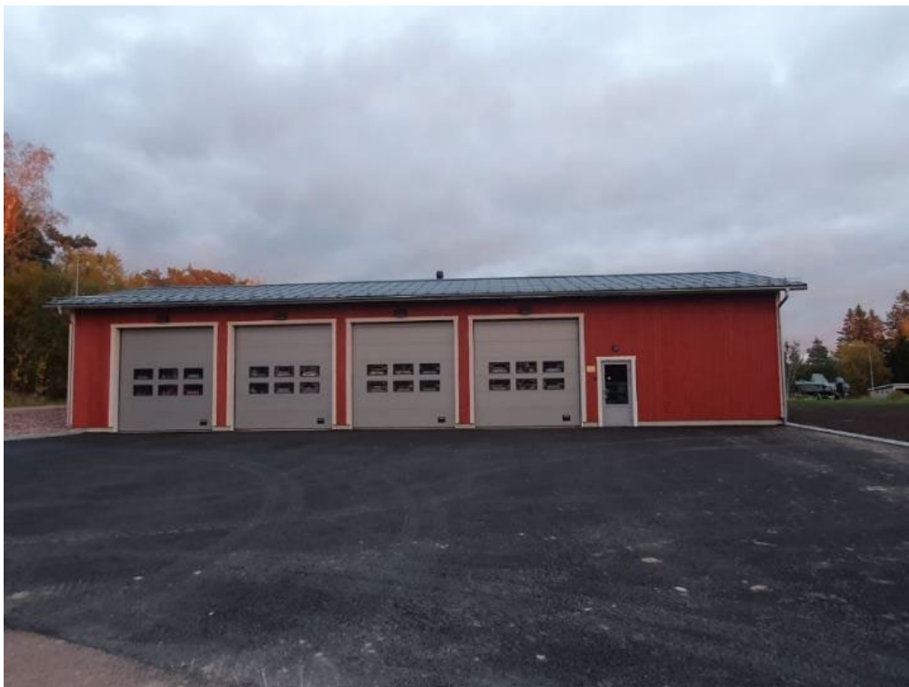
Kuva 7. Tämä Ahvenanmaalle rakennettu paloasema on Jomala FBK rf:n käytössä. Autotallin kerros-pinta-ala on noin 175 m 2 . Jomala FBK rf sai hankkeeseen avustusta 51 881 euroa. Kuva: Jomala FBK/Palosuojelurahasto.
